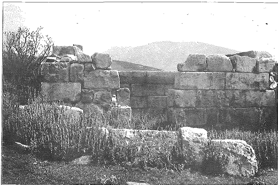
1. Innenseite eines Turmes vom Nordosteck von Echinon mit isodomen Quadern
