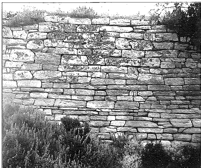
2. Archaische Mauer aus Plattensteinen an der Akropolis von Gonnos
