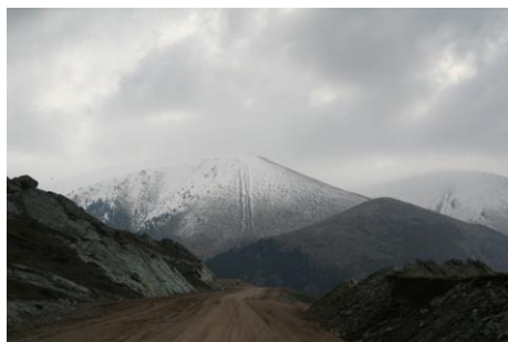
Εικόνα 41: Ο δρόμος πριν την ασφαλτόστρωση.
